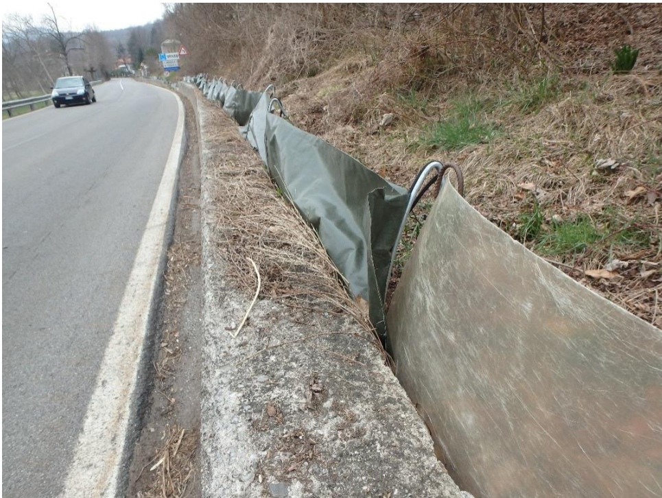
Un particolare della posa delle barriere temporanee presso i sottopassi per anfibi di Brinzio. L'immagine mostra un'interruzione che è stata eliminata dopo la segnalazione ai volontari.
